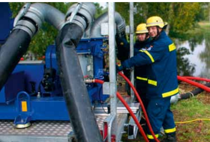
THW im Hochwassereinsatz an der Schwarzen Elster
